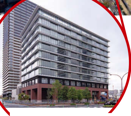
OHK 新オフィスは10階建てオフィス棟の8～10階を区分所有
